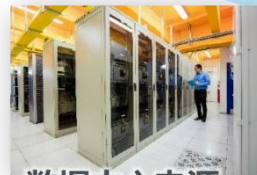
数据中心电源
